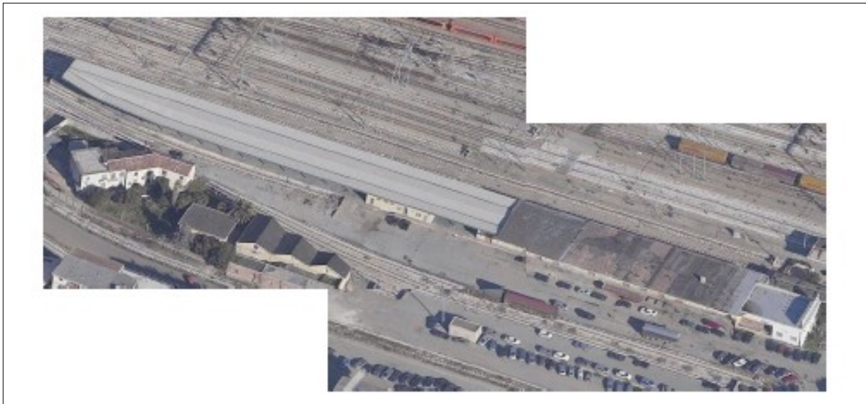
Figura 2 - gli edifici dello Scalo Merci della stazione di Foggia.
